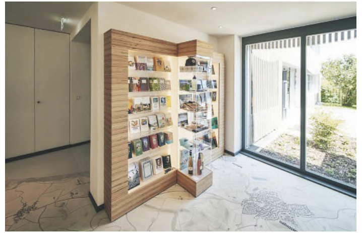
/ Was optisch leicht wirkt, war eine konstruktive Herausforderung, denn die mittlere Vitrine lässt sich aufdrehen, um die Ausstellungsstücke auszutauschen.
